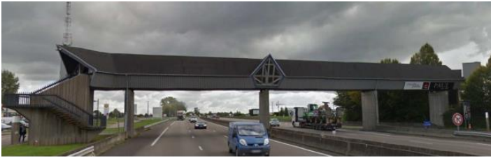
La passerelle de Bosgouët avant son démantèlement.
