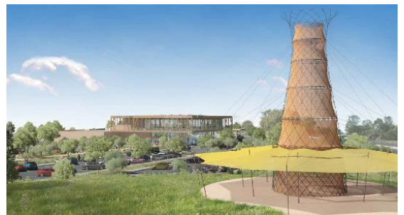
L'aire de Bosgouët Sud après rénovation. ©E. Leclerc Autoroutes.
